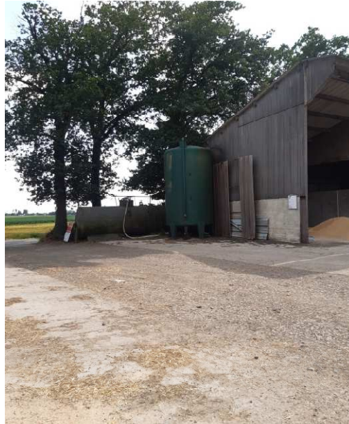
Cuve à azote
