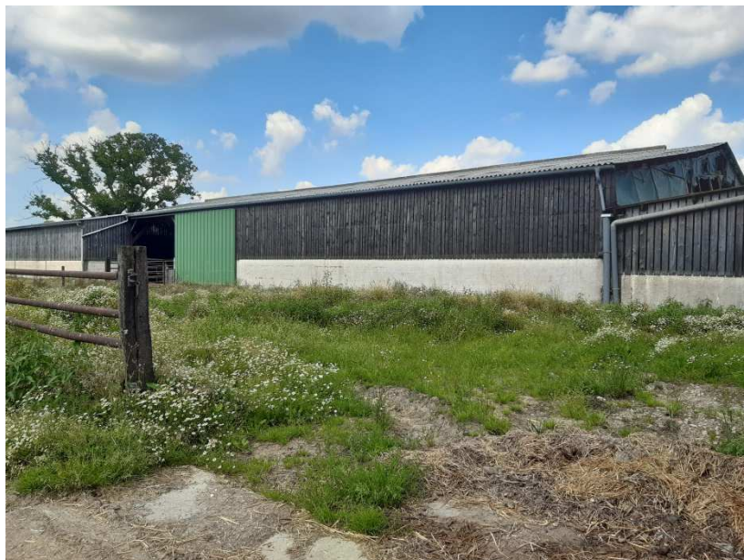
Bâtiment des vaches laitières
